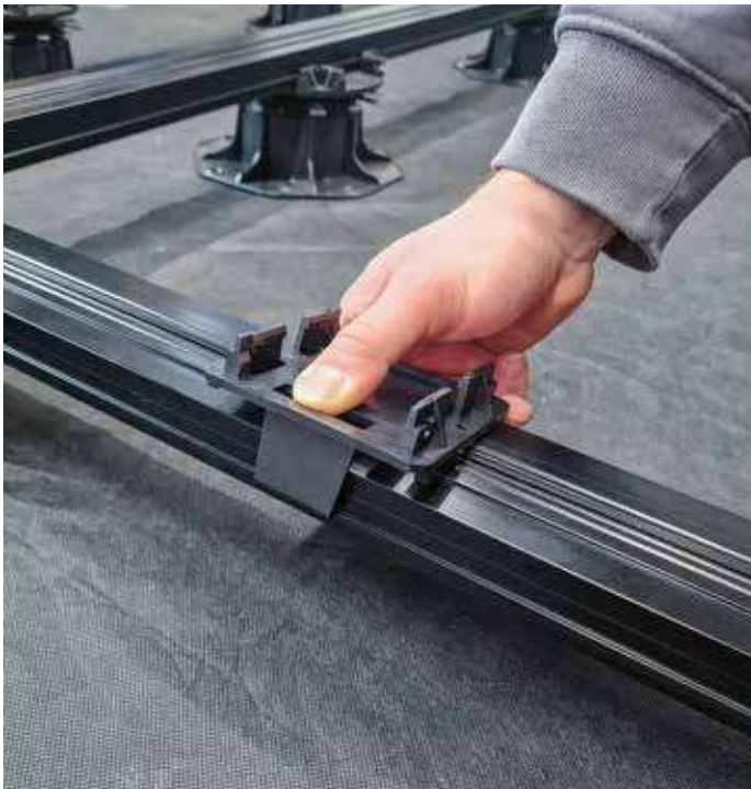
KL-Kreuzverbinder auf die ausgerichtete Konterlattung einklicken
