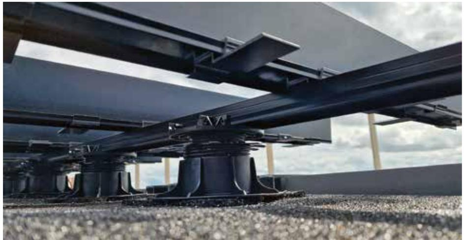
Beschwerung des Systems z. B. durch Beton- oder Stahl-Platten  $30 \times 30 \text{ cm}$  auf das geforderte Flächengewicht.
